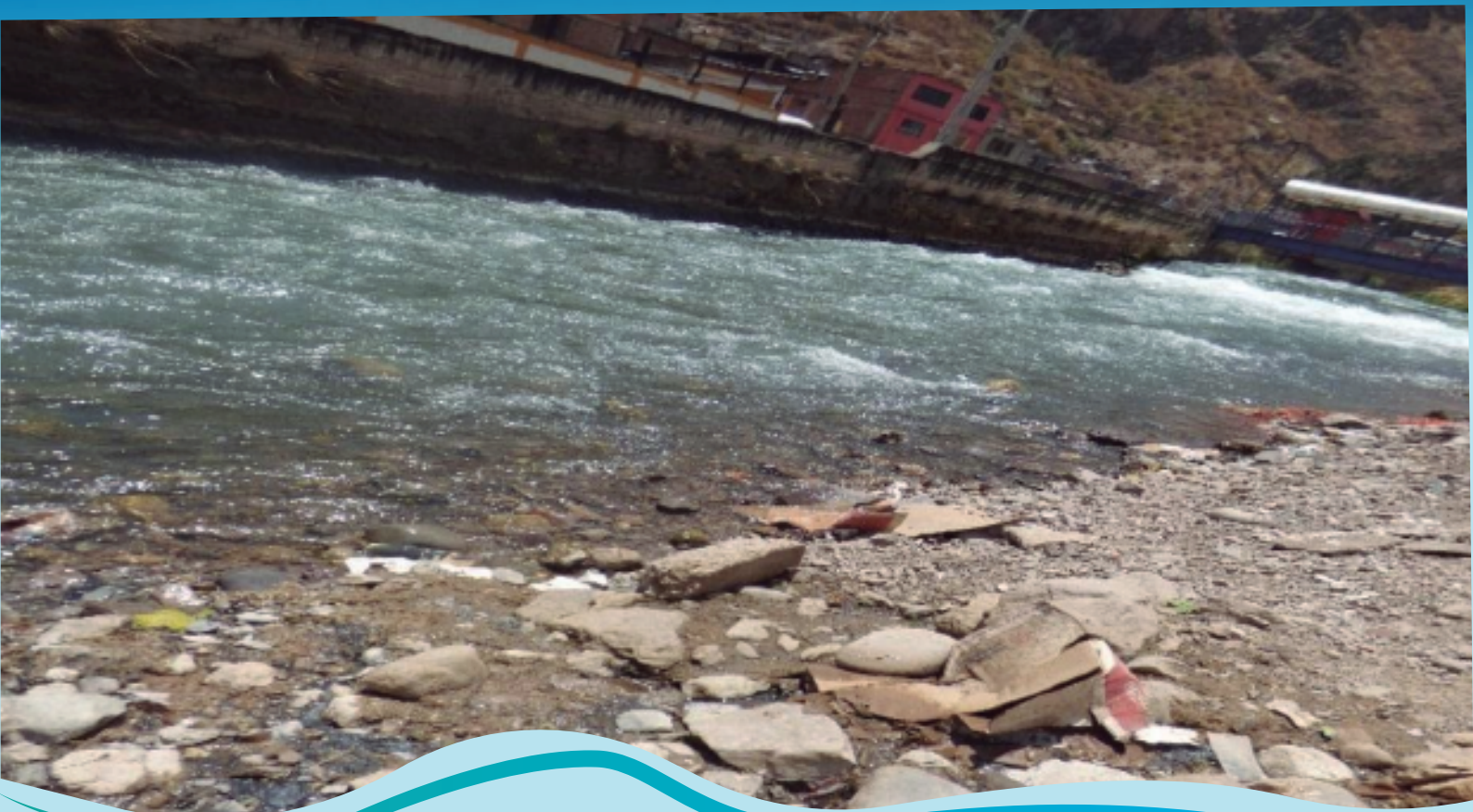
Descarga de aguas servidas al río Rímac
